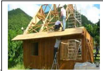
سقف خشبي رديء التوصيل للحرارة في المناطق الاستوائية
